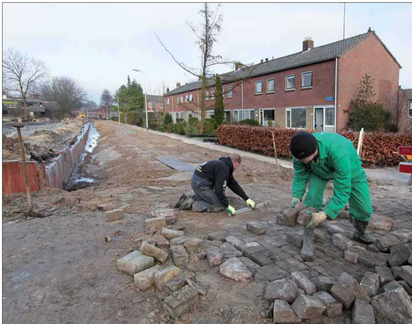
Werkzaamheden aan de Burefen
