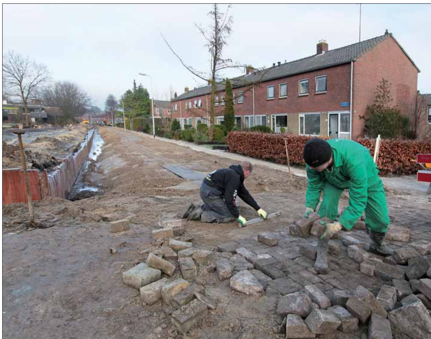
Werkzaamheden aan de Burefen
